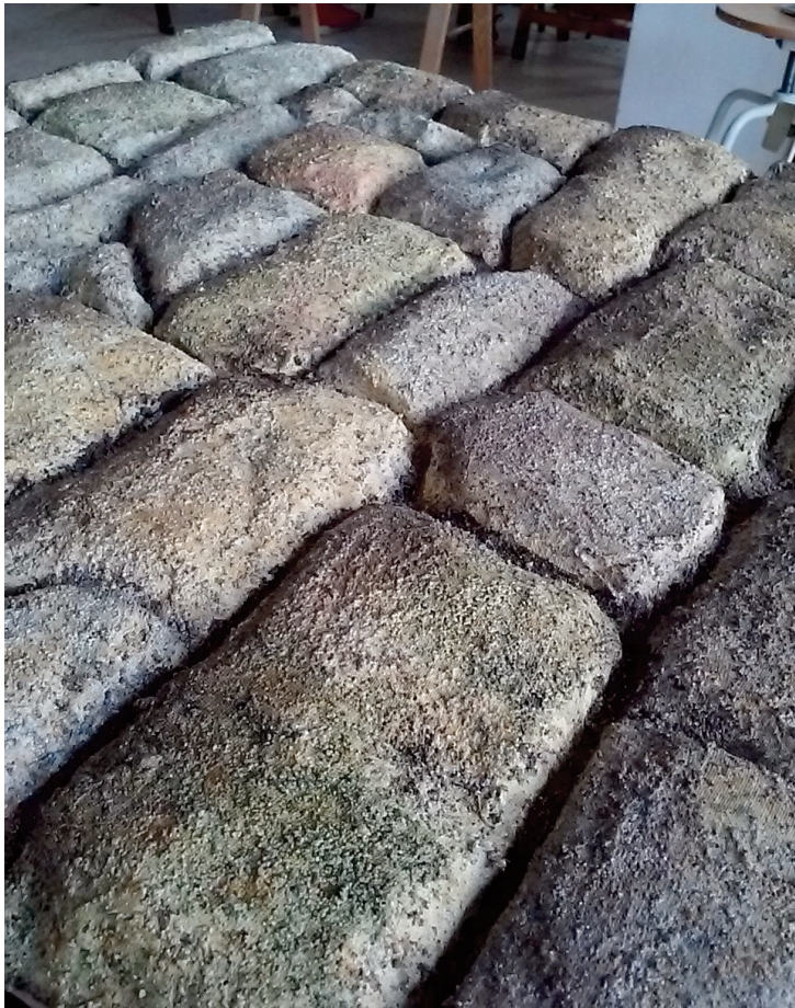
Immagine 46 - Muro a secco.
