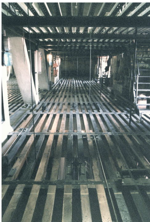
Foto 2 - Il graticcio in legno del Teatro Comunale di Bologna, a 30 m d'altezza, visto dal lato sinistro.
